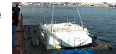
同ITER向けトロイダル磁場コイル輸送
