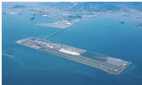
2027年8月に滑走路延伸を控える北九州空港
