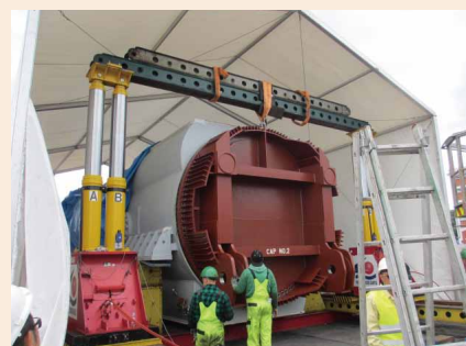
貨車接合用アタッチメントの取付作業
