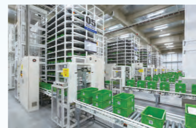
初めて導入したロータリーピースソーター
