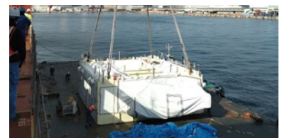
同ITER向けトロイダル磁場コイル輸送
