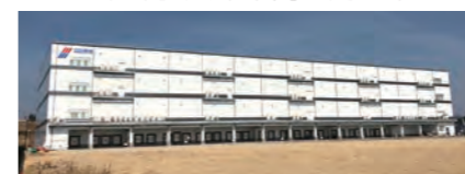
▲関西第二メディカル物流センター
