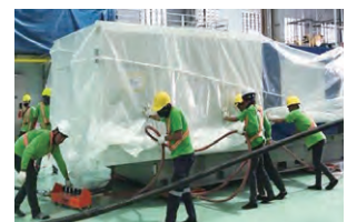
設備搬入作業(日本〜フィリピン)
