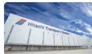
チカラン物流センター インドネシア・西ジャワ州 2016年4月稼働 日用品関連
