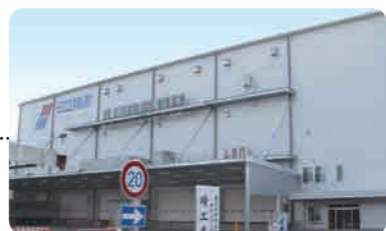
水戸プラットフォームセンター 茨城県ひたちなか市 2016年5月稼働 電気機械器具等
