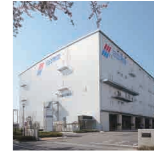
「R&Dセンタ」(既存物流センター4階)
