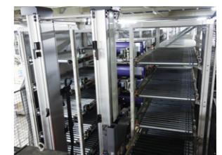
オリコン自動倉庫
